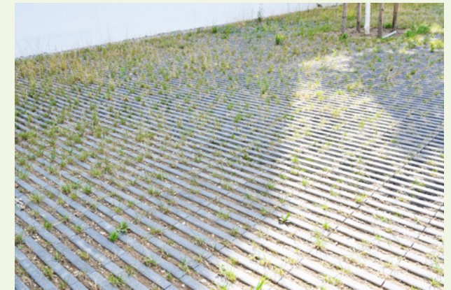
Diese Platten sind begrünt oder mit Splitt verfüllt regenwasserdurchlässig, gleichzeitig aber auch gut begeh- und auch für schwere Fahrzeuge befahrbar.
