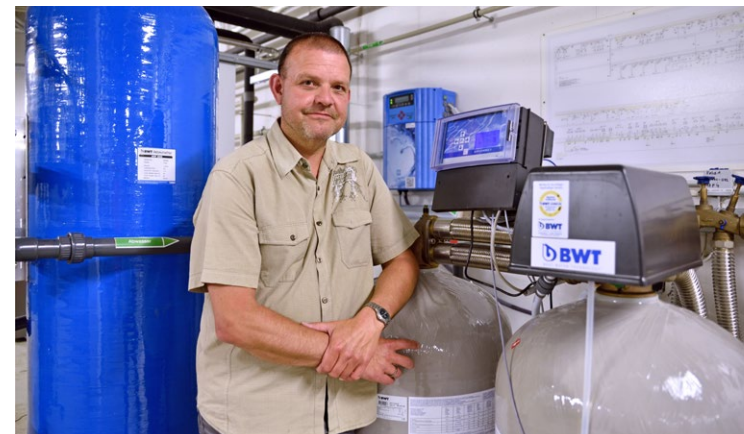
Holger Disse, Bereich Heizung/Sanitär, vor den Umkehrosmoseanlagen, die das Wasser nun umweltschonender aufbereiten.
