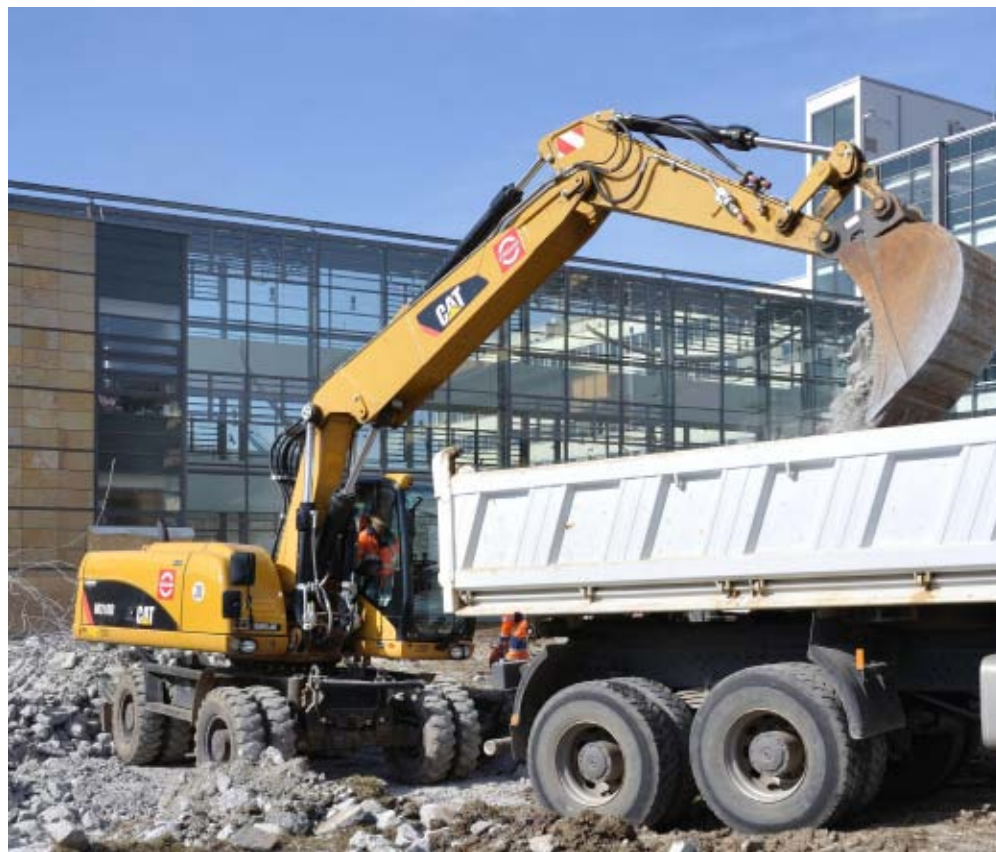
Baustelle Klinikum Lobeda: Im März begannen die Abrissarbeiten
