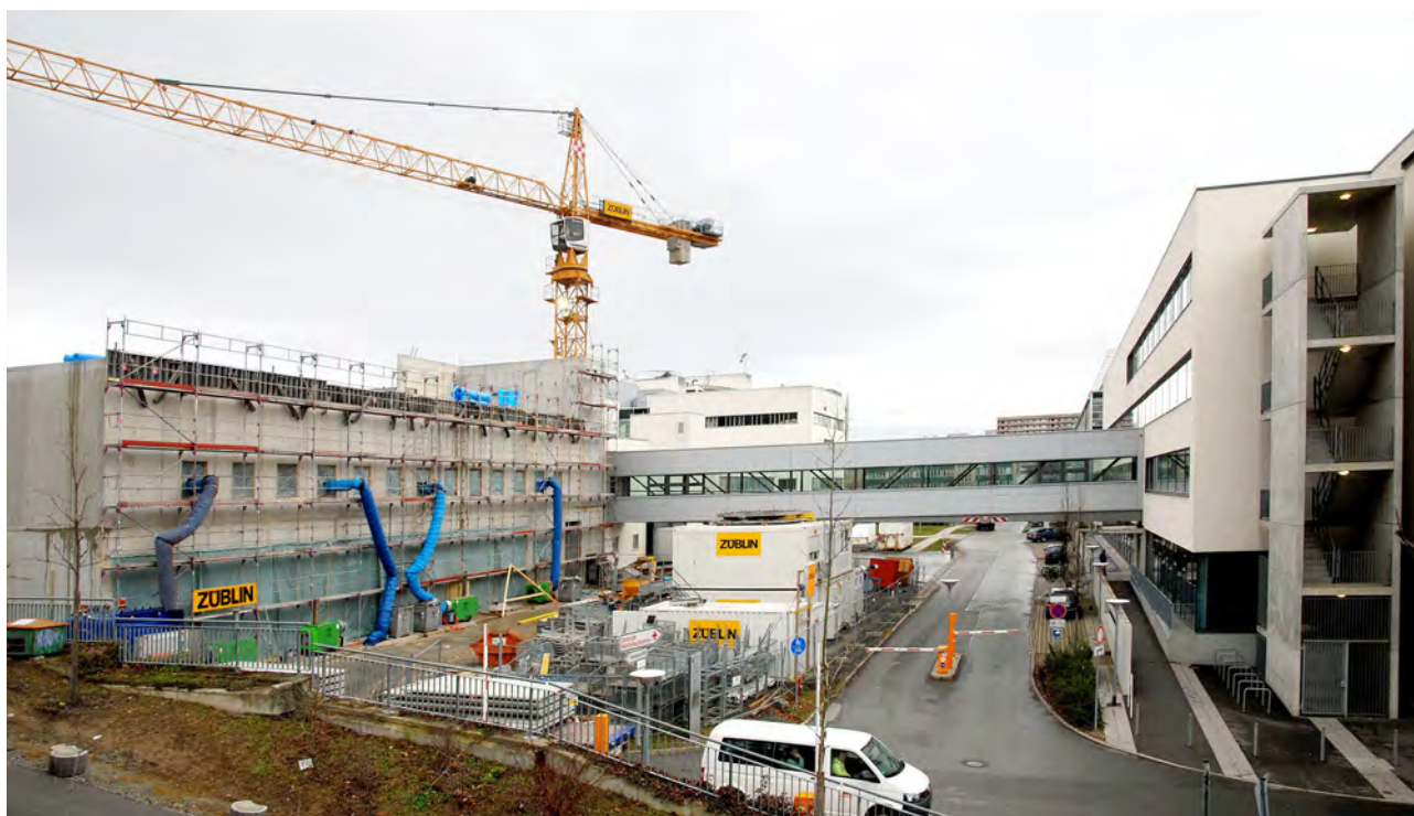
Die Baustelle des Erweiterungsbaus des Dienstleistungszentrums Anfang Januar 2013. Mitte nächsten Jahres soll der Neubau in Betrieb genommen werden. Foto: Vöckler
