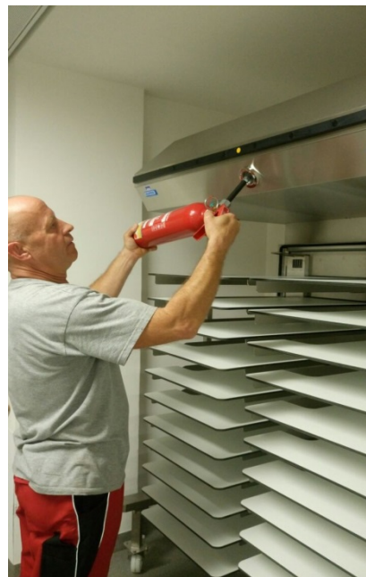
Abbildung 7 - CO 2 -Löcher zur Bekämpfung von Bränden in den Andockstationen der Essenswagen, aus Sicherheitsgründen ist es hier nicht zulässig sich beim Löschen auf Leitern oder Tritte zu stellen.
