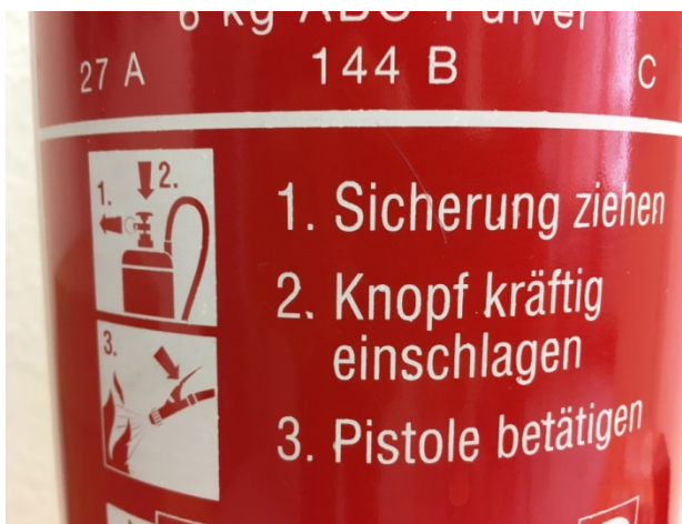
Abbildung 6 - Bedienungsanleitung auf Feuerlöscher
